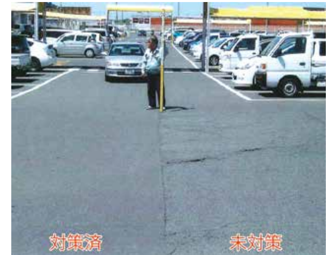
GDS工法の有無によるアスファルトの比較（茨城県 稲敷市）
