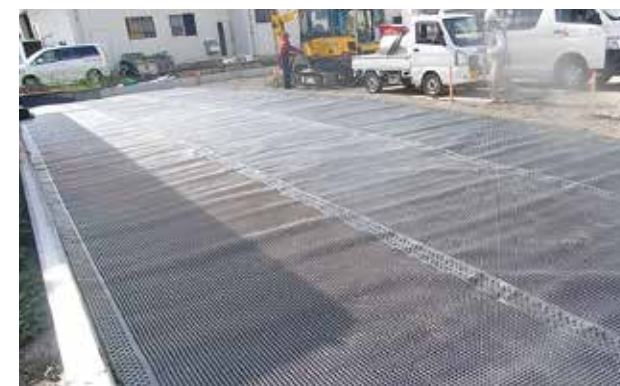
シートの敷設
